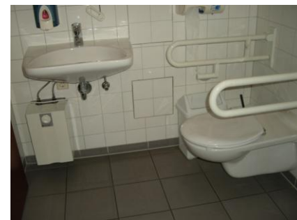
Abb. 11: WC in Haus 3
