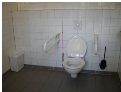
Abb. 9: WC in Haus 1
